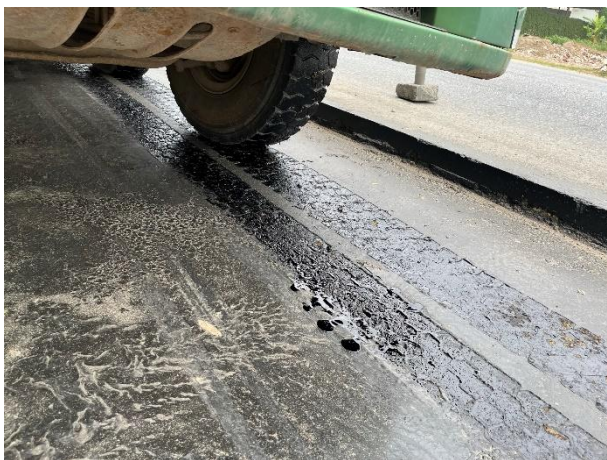
Bề mặt MC-70 khi xe vận chuyển BTN đi vào
