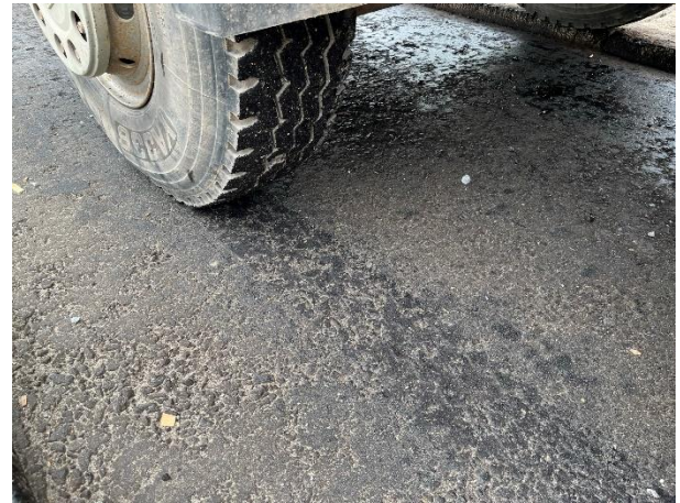
Bề mặt nhũ tương thấm bám đoạn móng khô khi xe vận chuyển BTN đi vào
