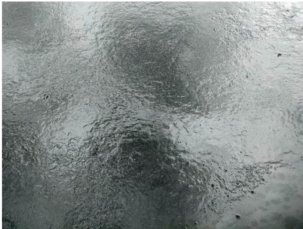
Bề mặt tươi MC-70 thời điểm sau khi tưới và sau 6 giờ
