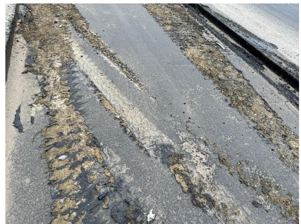
Bề mặt CSS-1 khi xe vận chuyển BTN đi vào
