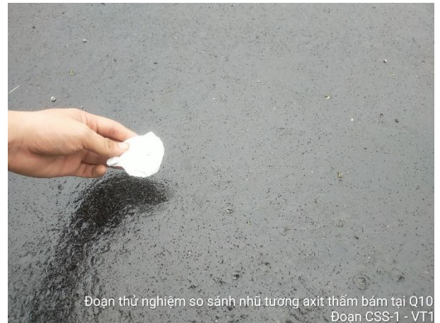
Bề mặt tươi CSS-1 thời điểm sau khi tưới và sau 4 giờ
