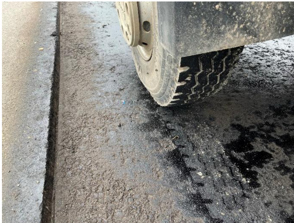
Bề mặt nhũ tương thấm bám đoạn móng ẩm khi xe vận chuyển BTN đi vào
