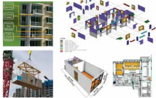
Hình 2. Ứng dụng công nghệ lắp ghép tấm lớn trong xây dựng NOXH
