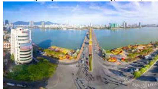
Hình 4. Nút giao thông, KGCC chân cầu Rồng - đường Bạch Đằng - Lê Duẩn TP Đà Nẵng long lẫy sắc màu đón Tết 2025
