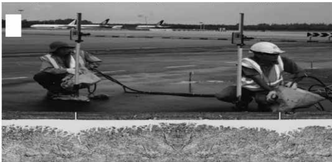
Hình 6. Mô hình nền móng mặt đường cứng sân bay khi được gia cố vữa Uretek [1]
