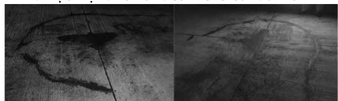
Hình 1. Tấm BTXM hư hỏng nứt vỡ tại đầu 25L/07R tại CHK quốc tế Tân Sơn Nhất [3]
