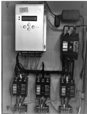
Hình 4. Mạch đo của thiết bị
