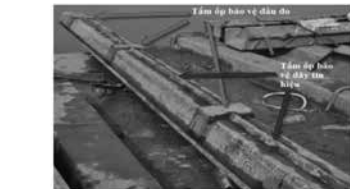
Hình 7. Một số hình ảnh lắp đặt các lá điện trở trên cọc thép thử nghiệm
