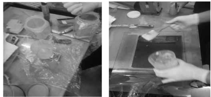
a) - Pha trộn keo theo tỷ lệ của nhà sản xuất b) - Tẩm keo nền Tyfo WS lên bề mặt thép
