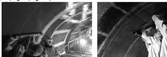
Hình 1. Thi công dán sợi trong đường ống áp lực ở nhà máy thủy điện
