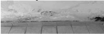
Hình 1. Hậu quả của thấm ngược do mao dẫn trong tường xây
