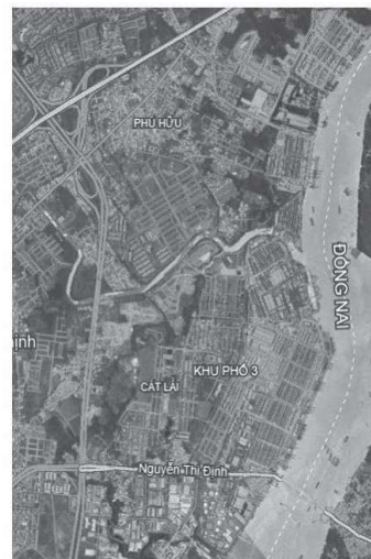
Hiện trạng tuyến giao thông độc đạo đến cảng Cát Lái (Ảnh vệ tinh, 2024)
