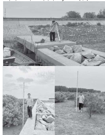
Hình 3. Một số hình ảnh khảo sát
