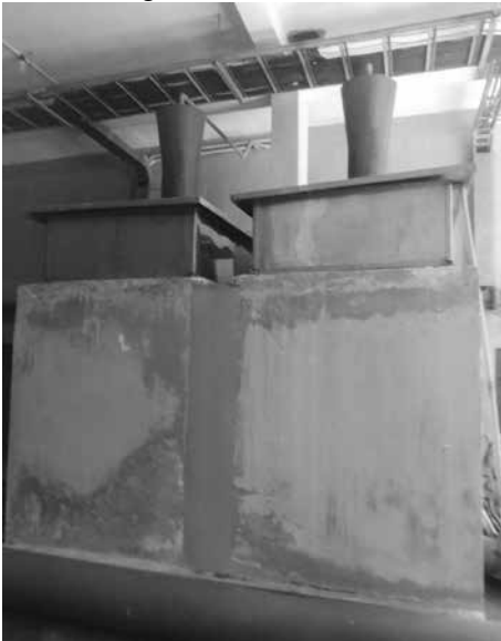
Hình 1. Các hố siphon thu nước của nhà máy nước A, huyện T.Ô. sai cao độ chuẩn 2.2.2. Thực trạng công tác cung cấp, bảo quản vật tư, thiết bị đầu vào sử dụng cho công trình
